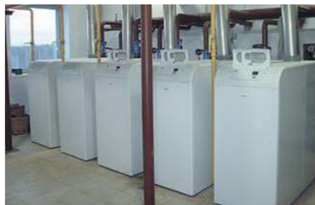
Кинотеатр, г. Йошка-Ола Общая мощность - 1,6 МВт
