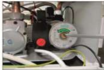
2. Отвинтите центральный винт с помощью отвертки
